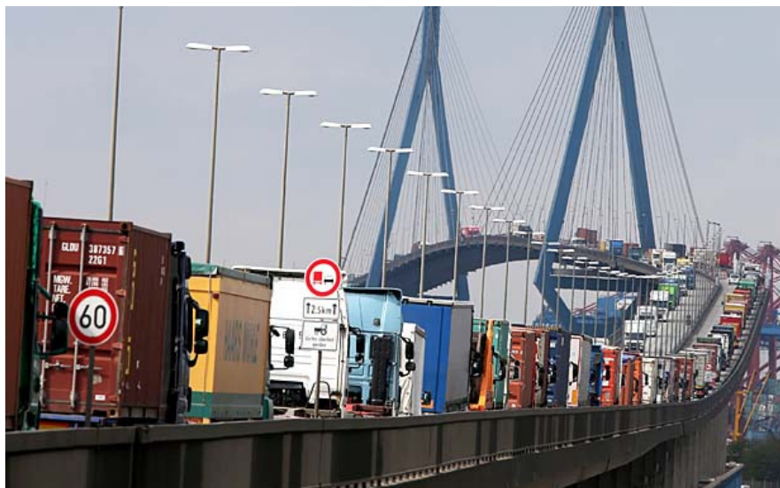
Auf der Hamburger Köhlbrandbrücke stauen sich die LKW
